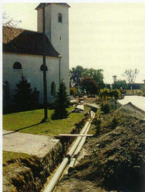
Fernwärmenetz in Seibersdorf mit Flexalen-Rohren.
